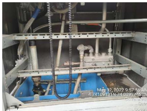
Foto 11. Sistema interno dispensador cuatro
