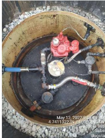
Foto 13. Bomba sumergible del tanque de gasolina corriente – Tanque 1
