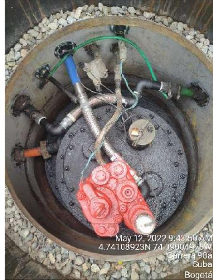
Foto 17. Bomba sumergible del tanque de ACPM-tanque 3A
