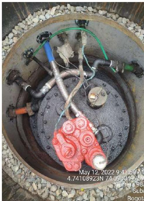
Foto 17. Bomba sumergible del tanque de ACPM- tanque 3A
