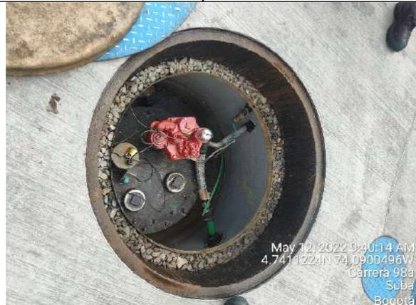
Foto 19. Bomba sumergible del tanque de gasolina extra - tanque 3B
