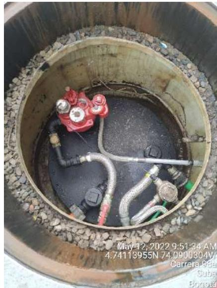
Foto 15. Bomba sumergible del tanque de gasolina corriente- tanque 2
