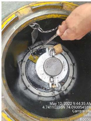
Foto 18. Spill-container del tanque de ACPM - tanque 3ª y cadena del sistema de retorno al tanque rota.
