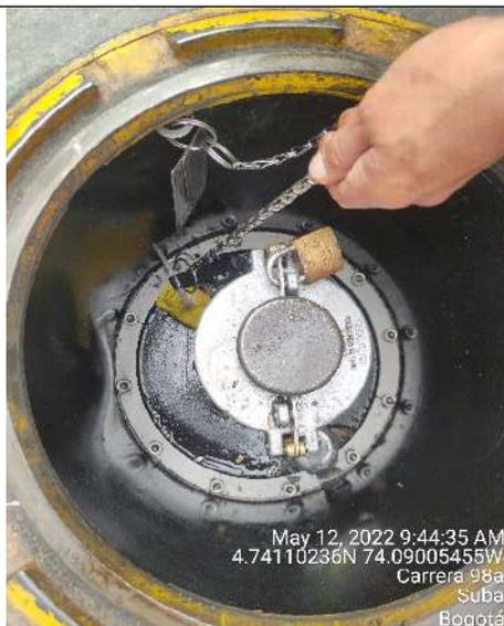
Foto 18. Spill-container del tanque de ACPM - tanque 3ª y cadena del sistema de retorno al tanque rota.
