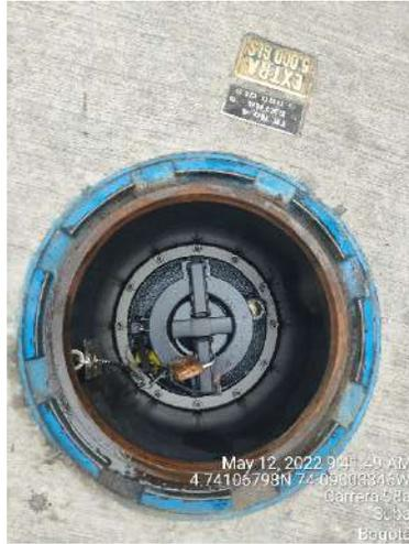
Foto 20. Spill-container del tanque de gasolina extra - tanque 3B
